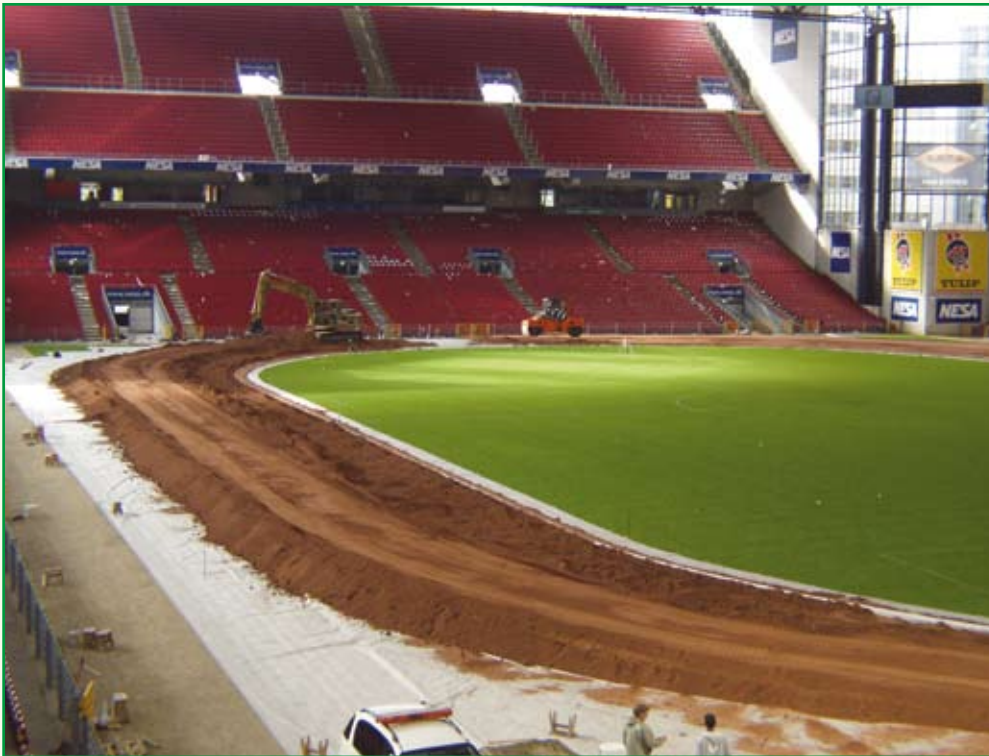
Typar® anvendes i Parken, København i forbindelse med anlæggelse af speedwaybane.
